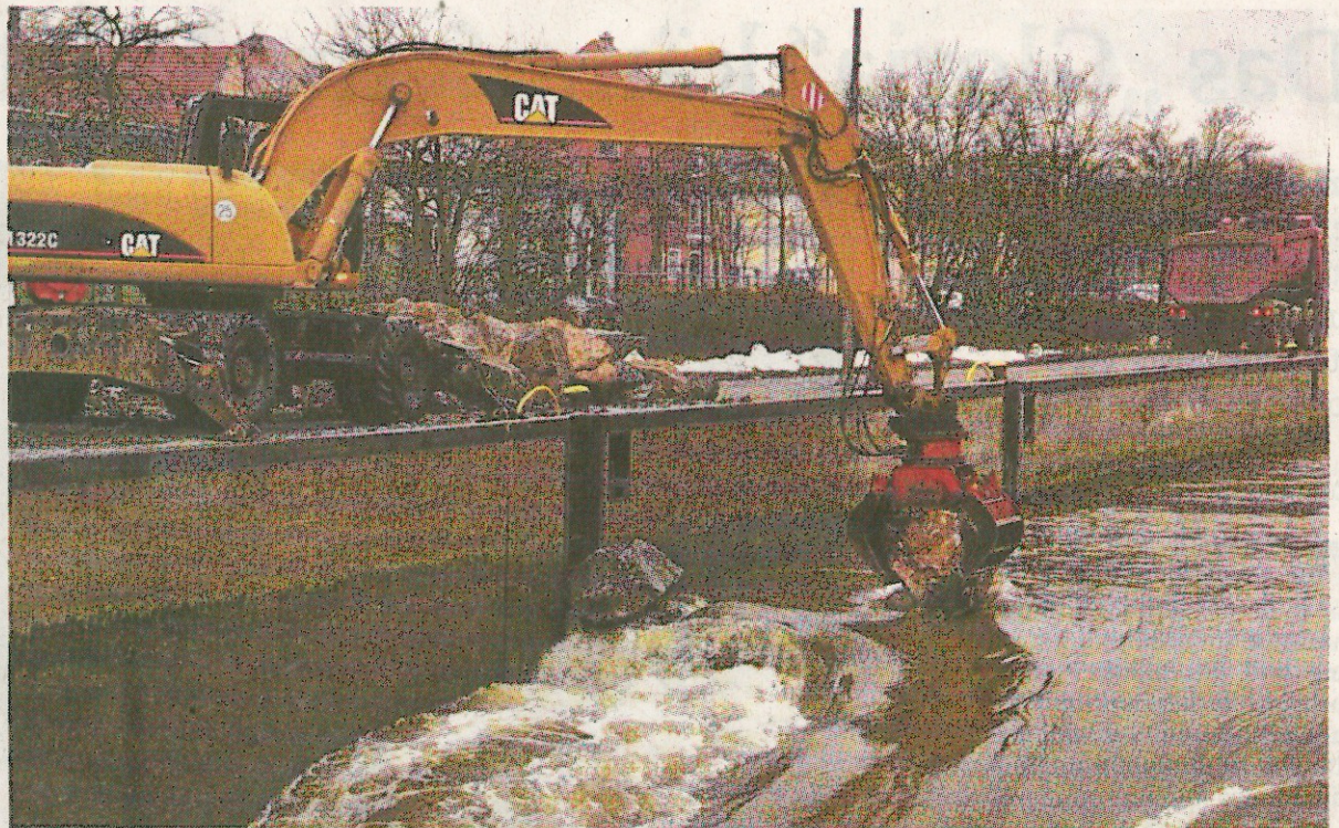
Im Kampf gegen die Wassermassen: Bagger schichteten jetzt einen Wall in der Donau auf.
